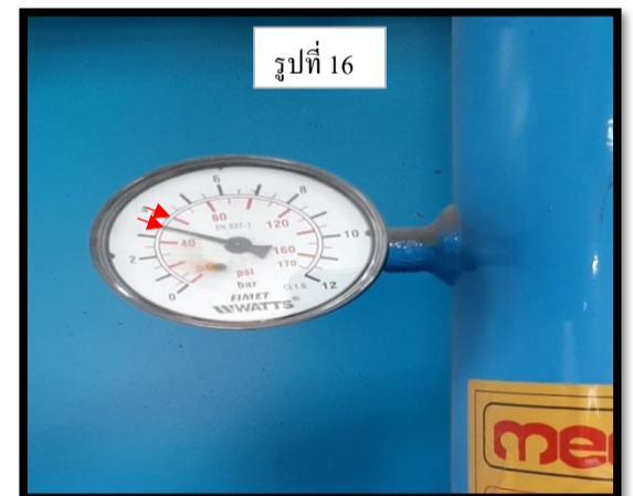
รูปที่ 16 เกจวัดแรงดันลมระบบ Pulse ใ้กรอง
