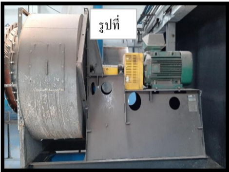
รูปที่1 Blower และ มอเตอร์ดูดอากาศ
